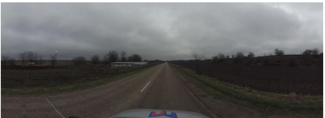
Рисунок 1.4.11 – Состояние дорожного покрытия а/д 03 ОП РЗ 03К-540 «х. Нееленский – х. Семеновка» на момент обследования
