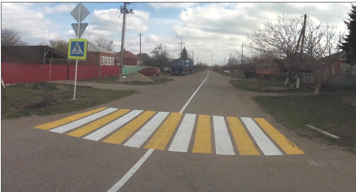
Рисунок 1.7.5 – Пример эксплуатационного состояния горизонтальной разметки 1.1 (разделяющей транспортные потоки противоположных направлений) и разметки 1.14.1 (обозначающей пешеходный переход) нанесённых по ул. Калинина в ст. Новолабинская
