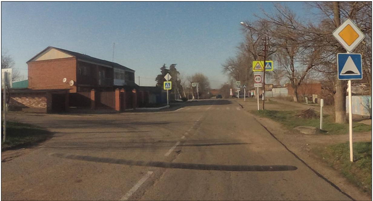
Рисунок 1.7.9 – Пример эксплуатационного состояния ИН сборно-разборной конструкции, расположенной по ул. Кубанская, п. Южный
