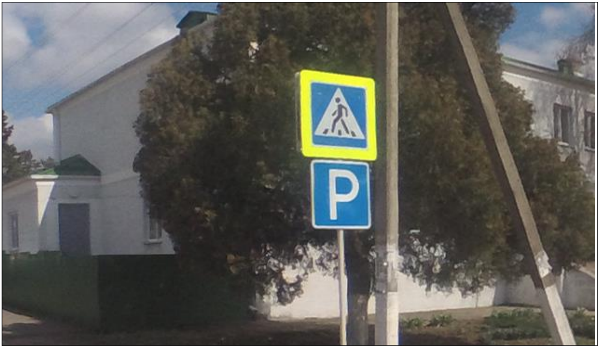
Рисунок 1.7.4 – Вид эксплуатационного состояния знака 5.19.1 «Пешеходный переход» на желтом фоне и знака 6.4 «Парковка (парковочное место)», расположенных по ул. Колхозная в ст. Тенгинская
