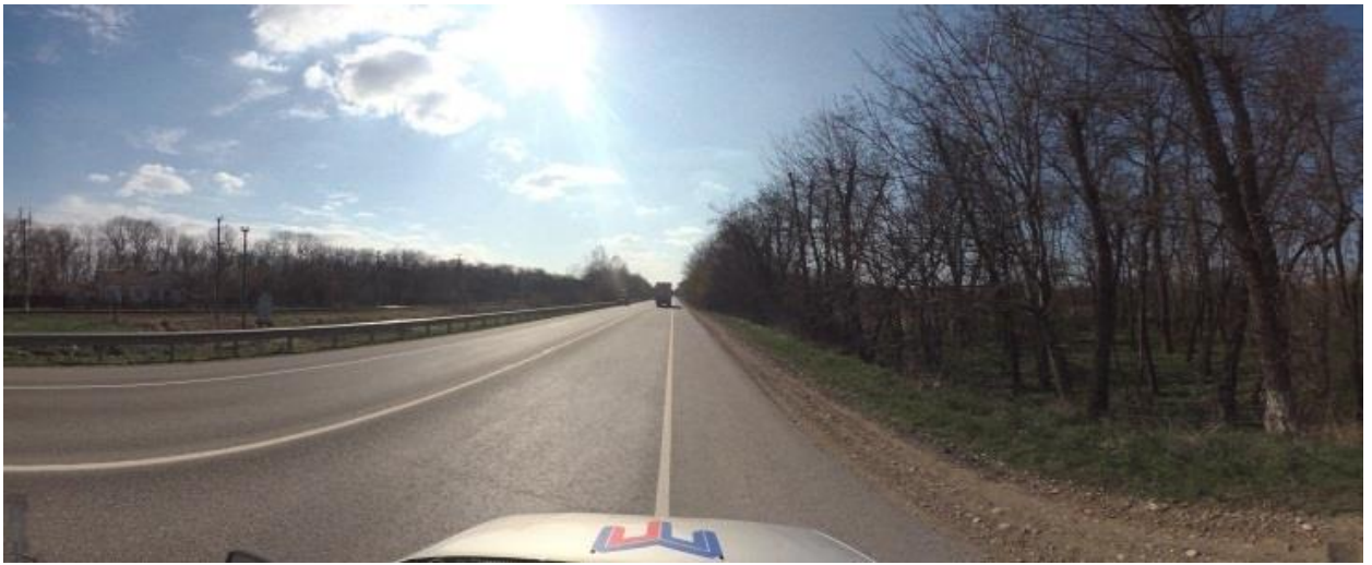
Рисунок 1.4.1 – Состояние дорожного покрытия а/д 03 ОП РЗ 03К-002 «г. Краснодар – г. Кропоткин – граница Ставропольского края» на момент обследования
