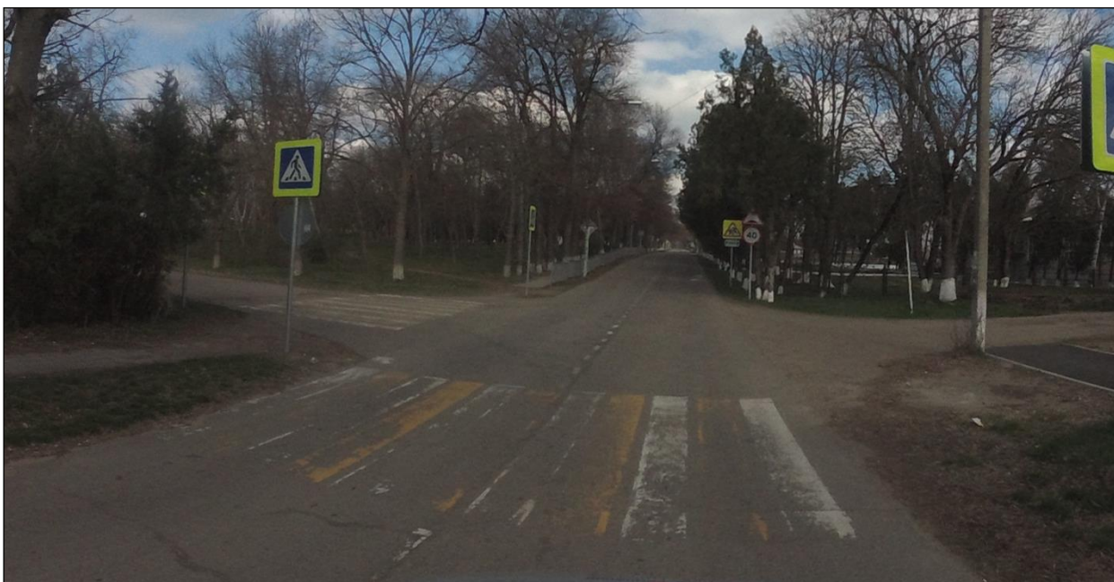
Рисунок 1.7.6 – Пример неудовлетворительного состояния разметки 1.1 (разделяющей транспортные потоки противоположных направлений) и разметки 1.14.1 (обозначающей пешеходный переход) нанесённых по ул. Мира в ст. Тенгинская
