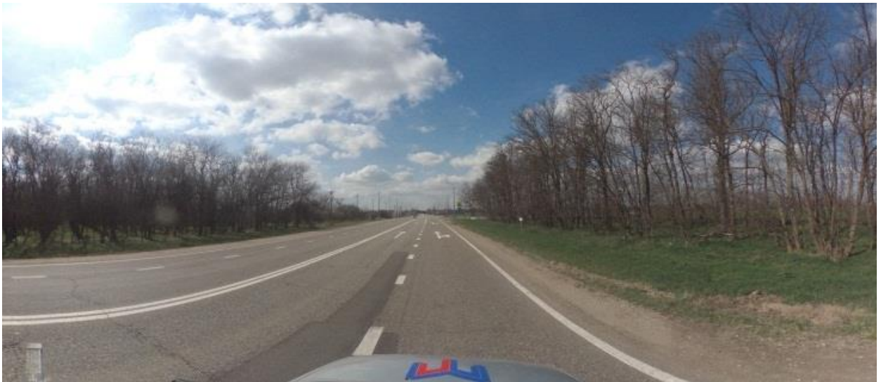
Рисунок 1.4.2 – Состояние дорожного покрытия а/д 03 ОП РЗ 03К-006 «г. Усть-Лабинск – г. Лабинск – ст-ца Упорная» на момент обследования
