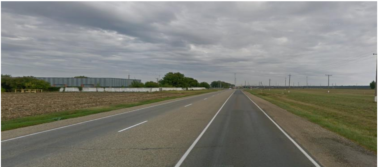
Рисунок 1.4.9 – Состояние дорожного покрытия а/д 03 ОП РЗ 03К-537 «Подъезд к г. Усть-Лабинск» на момент обследования
