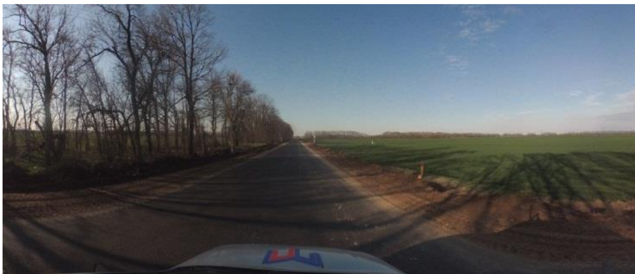
Рисунок 1.4.14 – Состояние дорожного покрытия а/д 03 ОП РЗ 03К-545 «Подъезд к п. Южный» на момент обследования
