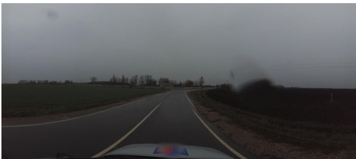
Рисунок 1.4.13 – Состояние дорожного покрытия а/д 03 ОП РЗ 03К-543 «Подъезд к х. Свободный» на момент обследования
