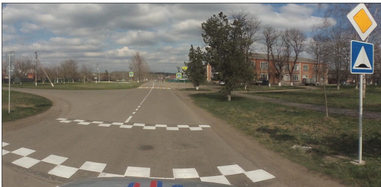
Рисунок 1.7.7 – Пример эксплуатационного состояния ИН неровности монолитной конструкции, расположенных по ул. Калинина в ст-це Новолабинская
