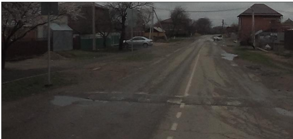
Рисунок 1.7.8 – Пример эксплуатационного состояния ИН монолитной конструкции не соответствующей нормативным требованиям, расположенной по ул. Коньшиных в ст. Ладожская
