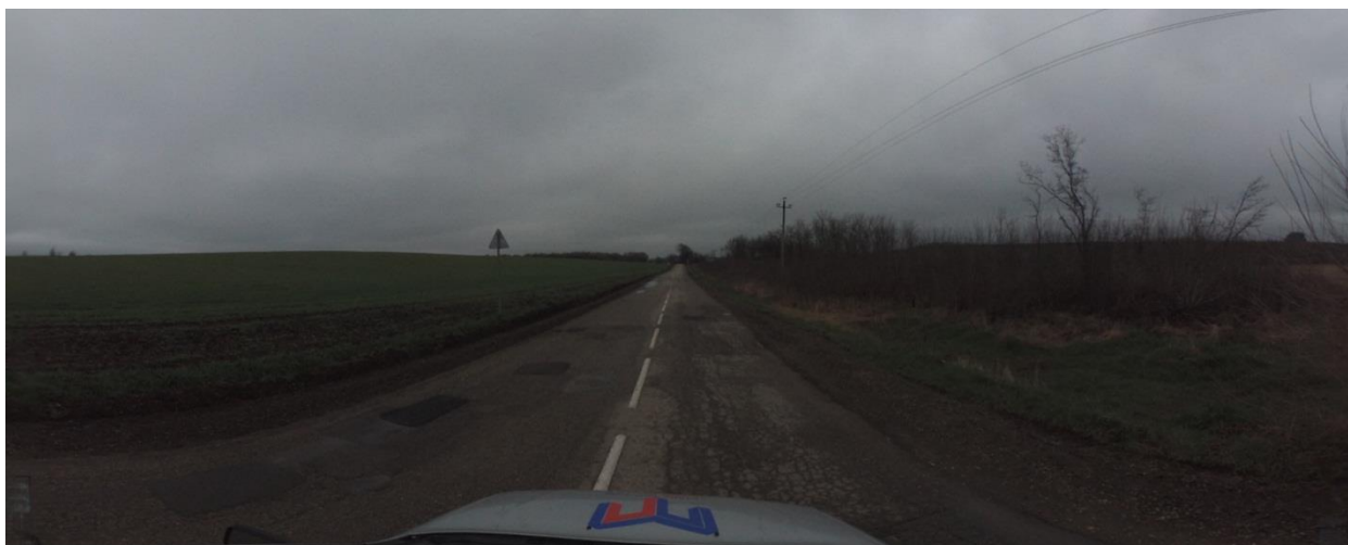
Рисунок 1.4.5 – Состояние дорожного покрытия а/д 03 ОП РЗ 03К-053 «ст-ца Ладожская – ст-ца Алексее-Тенгинская» на момент обследования
