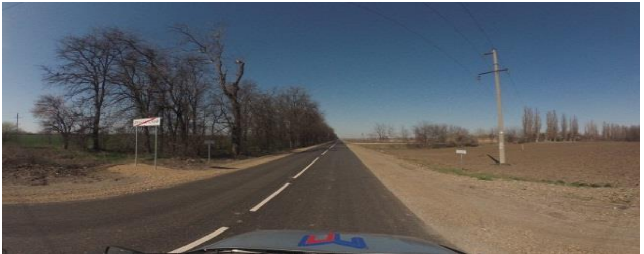
Рисунок 1.4.10 – Состояние дорожного покрытия а/д 03 ОП МЗ 03Н-539 «п. Двубратский – ст-ца Восточная» на момент обследования
