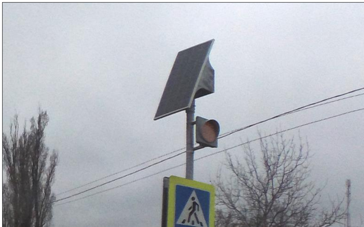
Рисунок 1.7.1 – Пример эксплуатационного состояния светофора Т.7, расположенного по ул. Ленина, х. Братский
