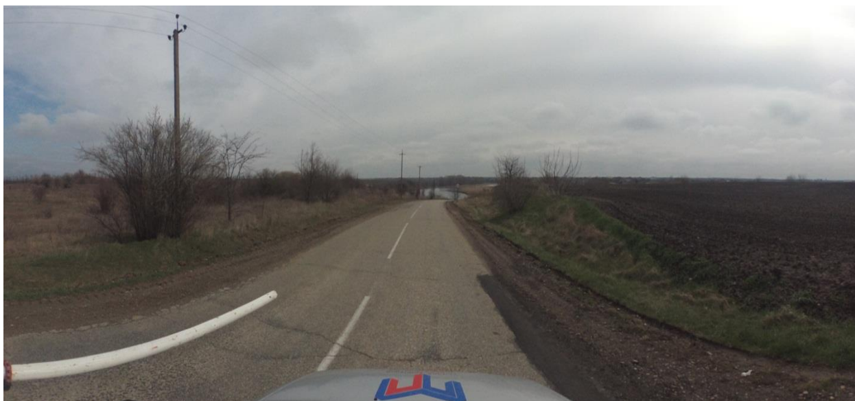
Рисунок 1.4.12 – Состояние дорожного покрытия а/д 03 ОП РЗ 03К-541 «Подъезд к х. Александровский» на момент обследования
