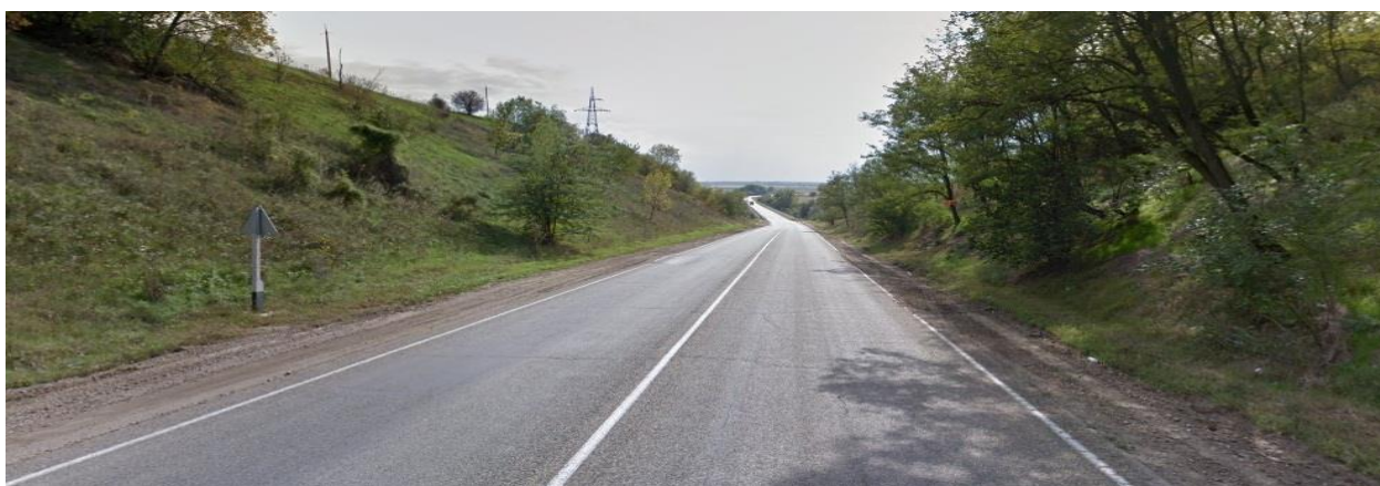
Рисунок 1.4.4 – Состояние дорожного покрытия а/д 03 ОП РЗ 03К-052 «ст-ца Некрасовская – а. Хатукай» на момент обследования
