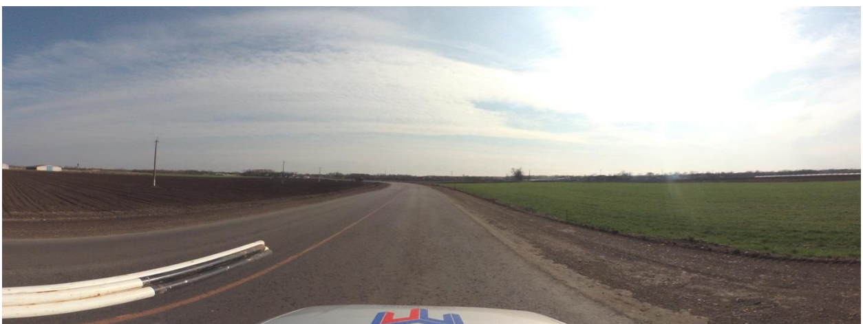
Рисунок 1.4.3 – Состояние дорожного покрытия а/д 03 ОП РЗ 03К-021 «ст-ца Выселки – ст-ца Кирпильская» на момент обследования
